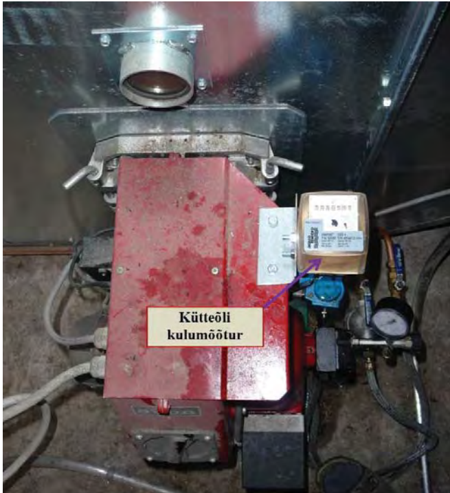
Joonis 4. Kulumõõturiga varustatud viljakuivati kütteõli põleti
