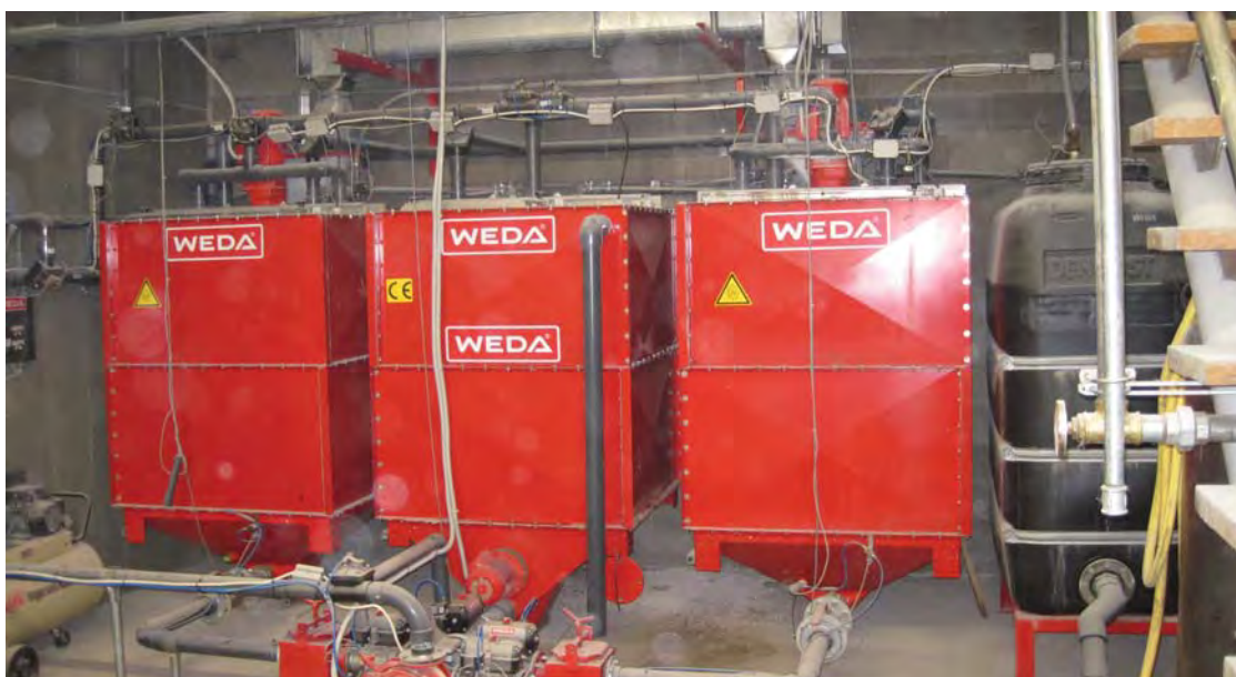
Automaatjuhtimisel toimiv seakasvatustalu jõusöödatsehh (foto: Väino Poikalainen)
