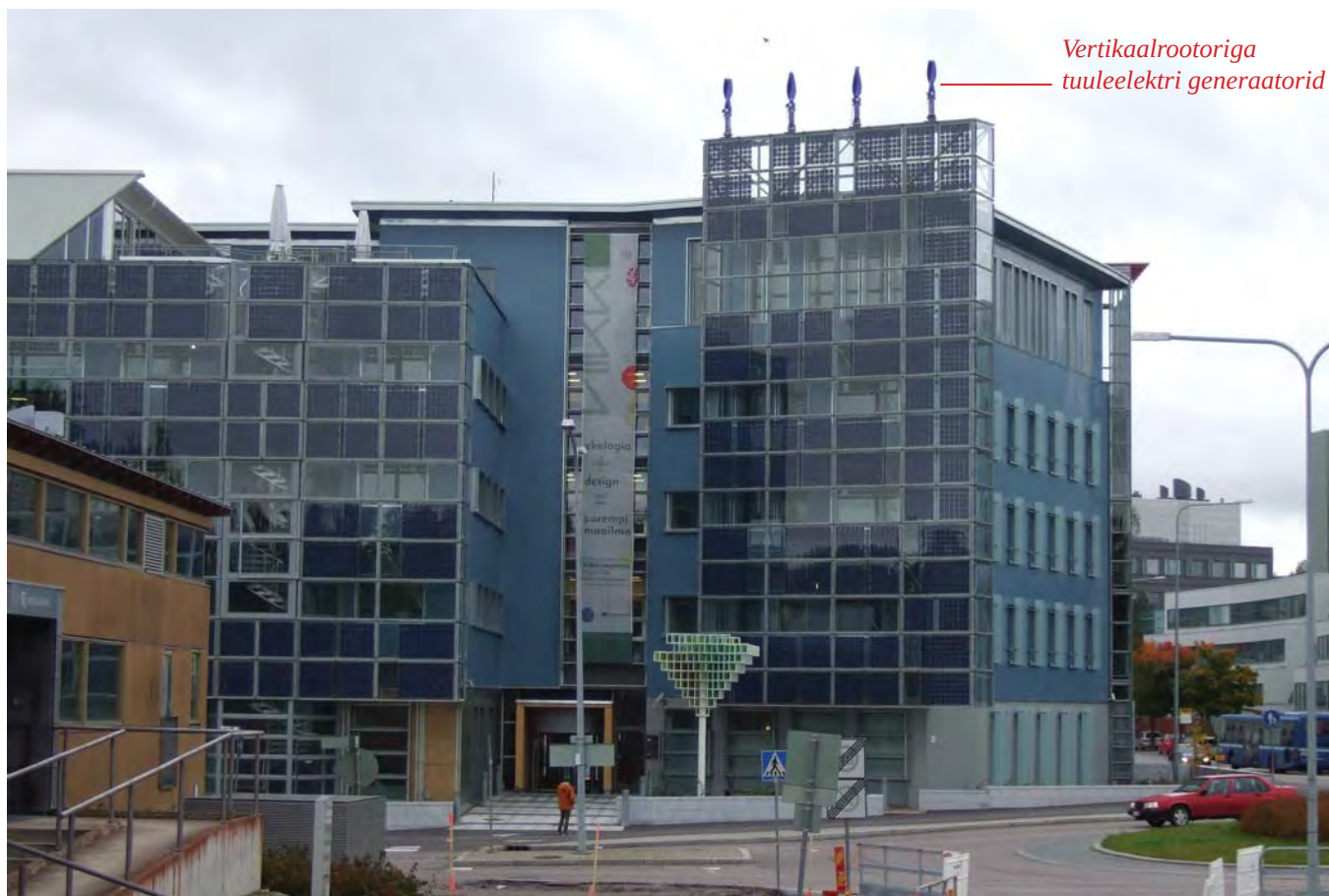
Joonis 11. Helsingi linna keskkonnamajas kasutatakse rohkesti päikesepaneele ja nelja soome päritolu vertikaalrootoriga tuuleelektrijaama (foto: Winfried Schäfer)
