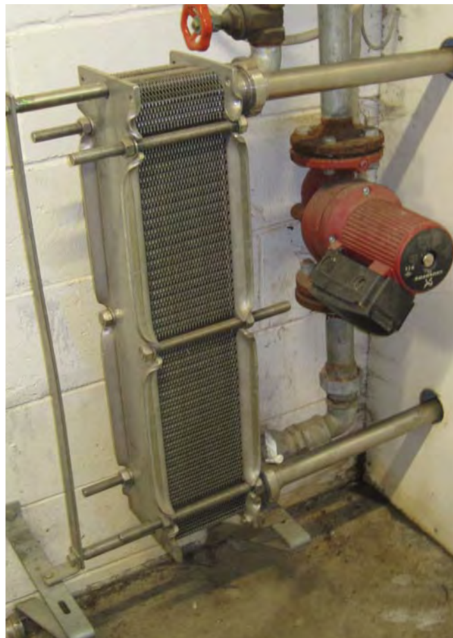
Joonis 32. Seiretalu piimatank (vasakul) ja plaatsoojusvaheti lüpstava piima soojuse taaskasutuseks (paremal)
