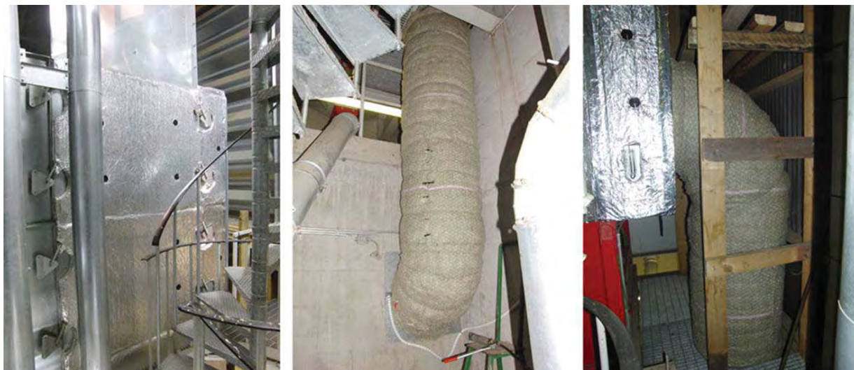
Joonis 19. Kuivati kuumade metallpindade isoleerimise näide
