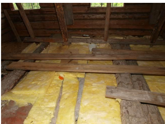
Fig. 14. Inefficient thermal insulation
