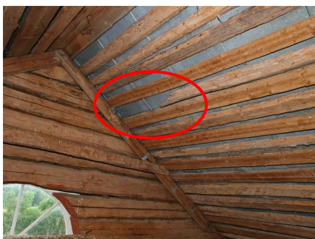
Fig. 9. Broken balk
